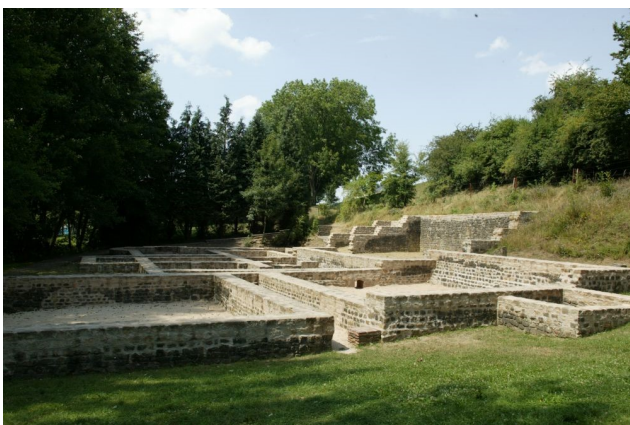
Restaurierte Mauerzüge der Thermen in Mamer.
